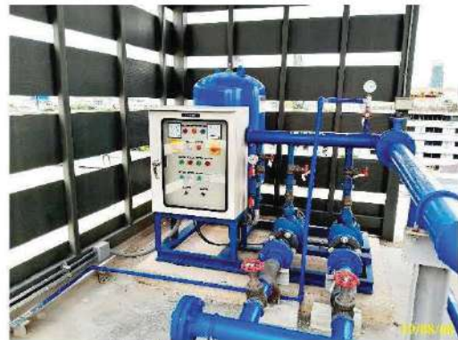
ถังสำรองน้ำใช้ชั้นตาดฟ้า พร้อมเครื่องปั๊มน้ำ
