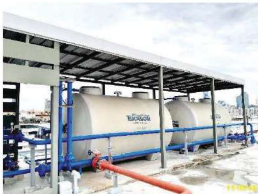
ถังสำรองน้ำใช้ชั้นตาดฟ้า พร้อมเครื่องปั๊มน้ำ
