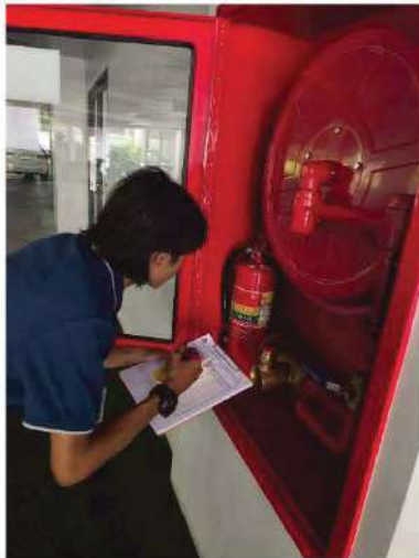
ช่างตรวจเช็คอุปกรณ์ป้องกันและแจ้งเหตุเพลิงไหม้
