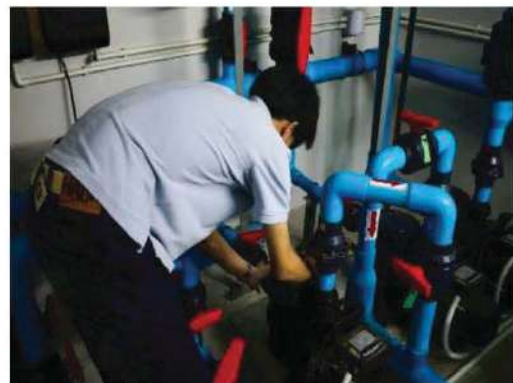
ช่างตรวจสอบระบบกรองสระว่ายน้ำ
