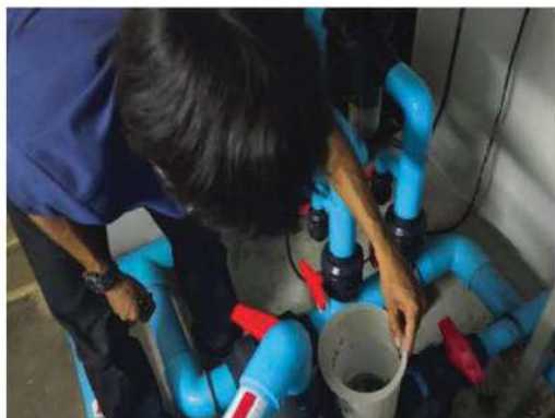
ช่างตรวจสอบระบบกรองสระว่ายน้ำ
